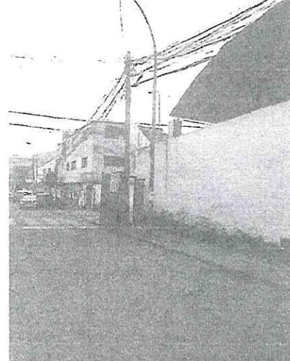
Img04.- Vista desde el frente del poste referido en Img02 sobre carga de cables en toda dirección.
