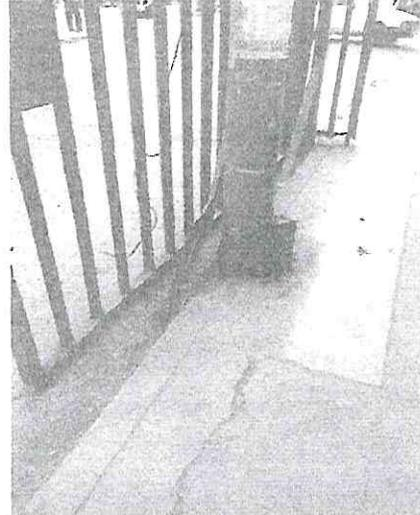
Img. 02.- Base de Poste con exposición de acero, inclinación del elemento por sobre carga de tensión.
